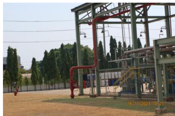
ภาพถ่ายที่ 2.2.2-40 ระบบดับเพลิงบริเวณถังเก็บอะคริโลไนไตรล์
