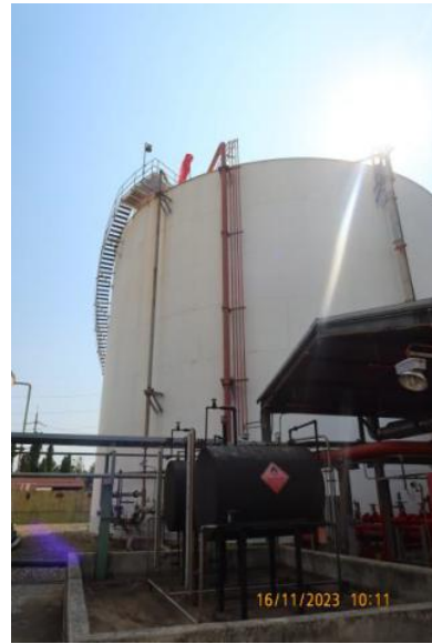
ภาพถ่ายที่ 2.2.2-42 ถังสำรองน้ำดับเพลิงและปั้มน้ำดับเพลิง
