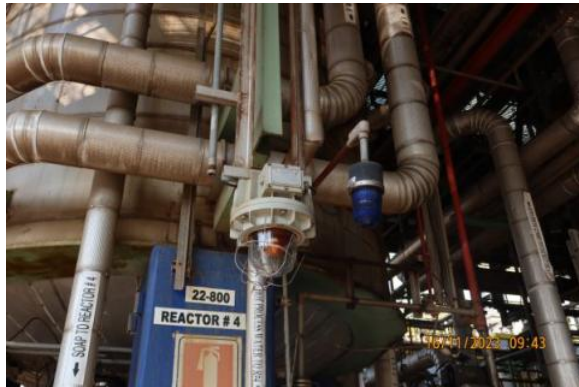
ภาพถ่ายที่ 2.2.2-33 อุปกรณ์ตรวจจับและเตือน (Detection & Alarm)
