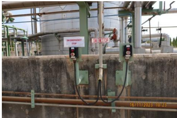
ภาพถ่ายที่ 2.2.2-39 ระบบความปลอดภัย บริเวณถังเก็บสไตรีน และถังเก็บอะคริโลไนไตรล์
