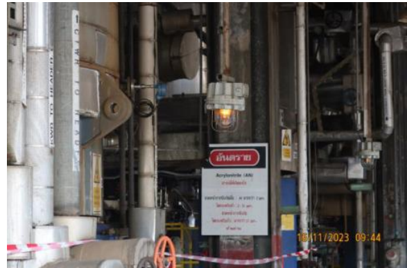
ภาพถ่ายที่ 2.2.2-33 อุปกรณ์ตรวจจับและเตือน (Detection & Alarm)
